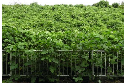
図-1 クズが繁茂した道路法面の眺め（最下段の
