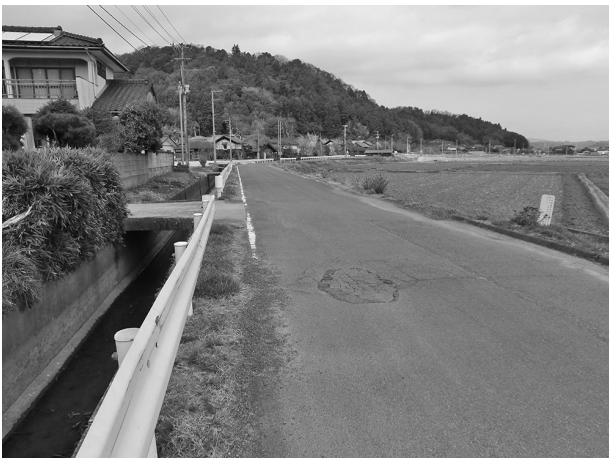
写真-3 水路と山麓の間に集落の家屋が存在する区間
