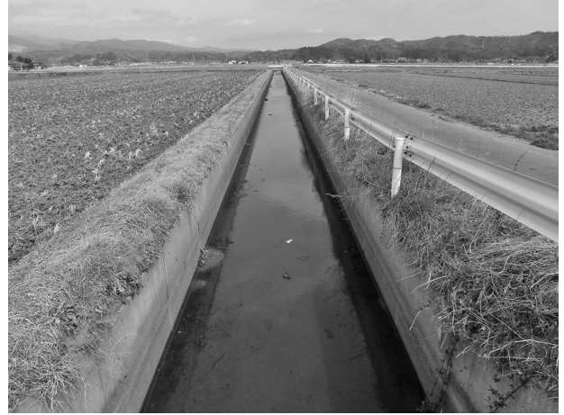
写真-4 水路が山麓から離れ両側が開けている区間
